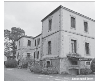
Το κτίριο της «σχολής» πριν αρχίσει η συντήρησή του
