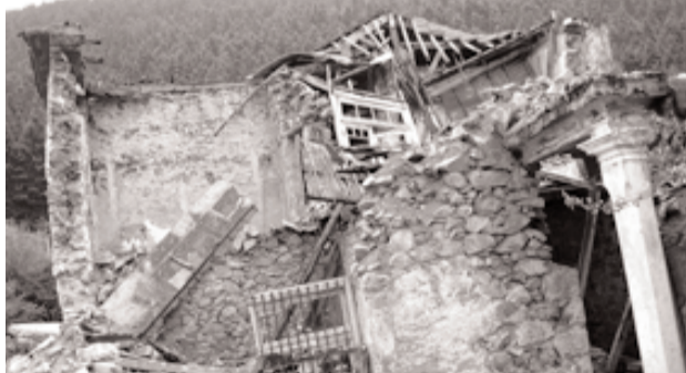
Το σημερινό «κατάντημα» του άλλοτε λαμπρού κτιρίου.
