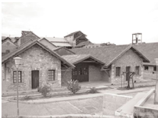
Οι ανακαινισμένες παλιές εγκαταστάσεις των μεταλλείων.
