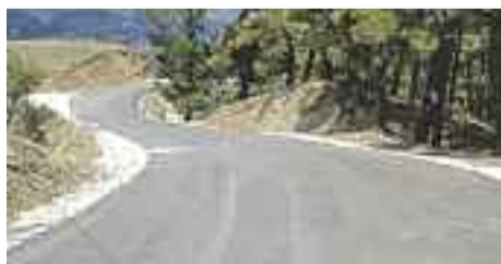
ΑΣΦΑΛΤΟΣΤΡΩΣΗ ΔΡΟΜΟΥ Π. ΒΥΤΙΝΑΣ
