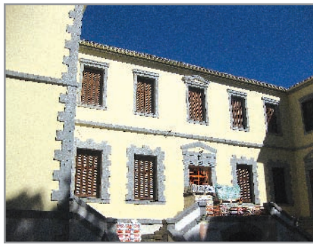
Τα επισκευασθέντα κτίρια της «σχολής» που μπορούν να στεγάσουν το κέντρο
