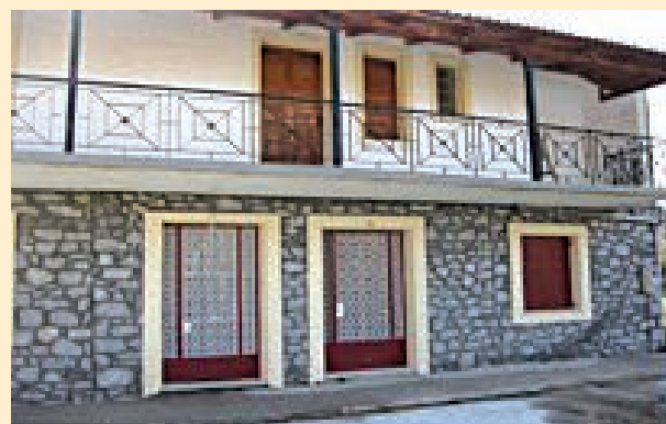
Το ανακαινισμένο κτίριο του κληροδοτήματος Θαλασσινού, που στεγάζει τις δραστηριότητες του πολιτιστικού συλλόγου
